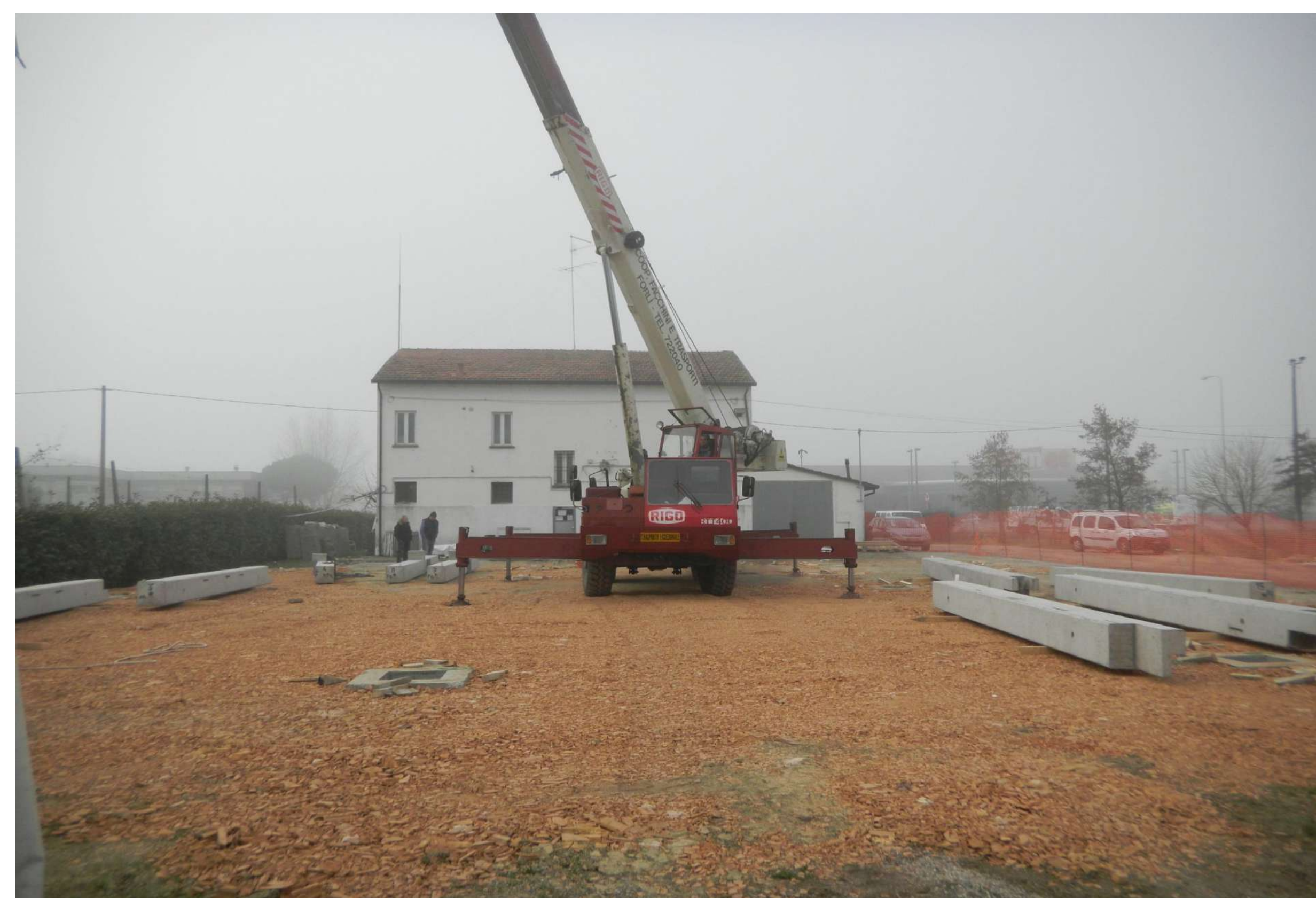
Inizio lavori di costruzioni del nuovo fabbricato polivalente
