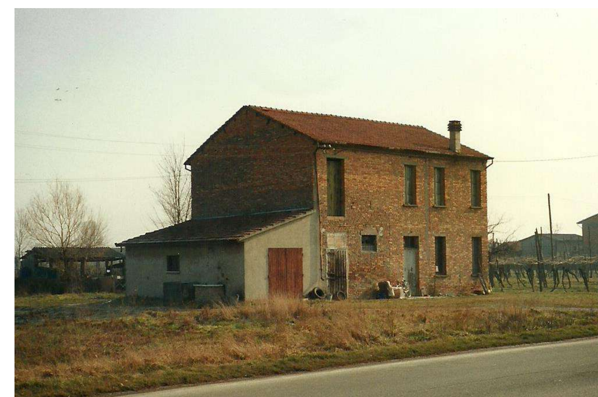
Attuale Sede prima dei lavori di restauro
