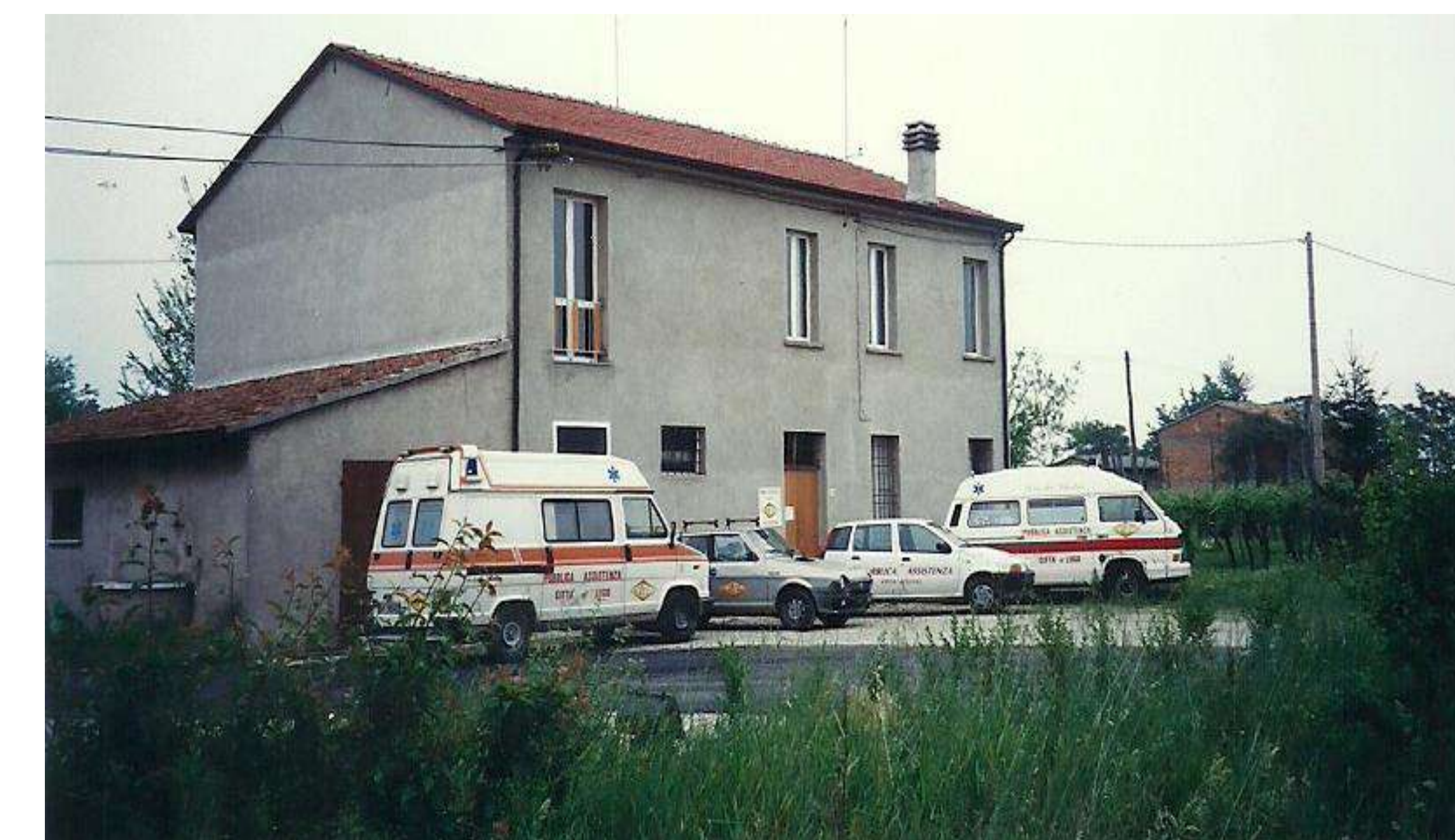
Attuale Sede dopo i primi lavori di restauro
